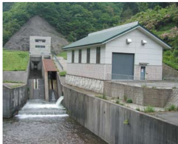
環境にやさしい小水力発電所(南砺市 白中発電所)
