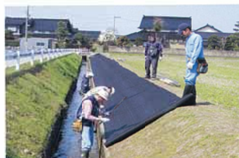
防草シート張り付け作業
