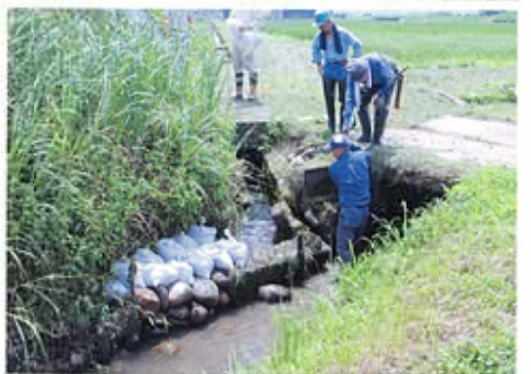
・大排下流の不法投棄物処理及び川底杭除去(切断)、雑木除去(切断)並びに側壁破損修理。
