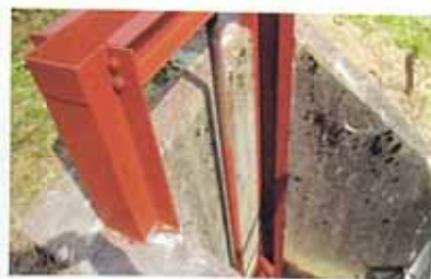
ブレハブ排水路の損傷が著しいため、排水路底張りコンクリートを施工(250m)
