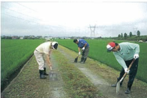
“農道の補修作業(ダストの散布)”
