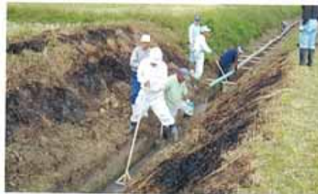
ブレハブ排水路の損傷が著しいため、排水路底張りコンクリートを施工(250m)
