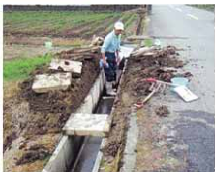
水路の目地コーティング作業
