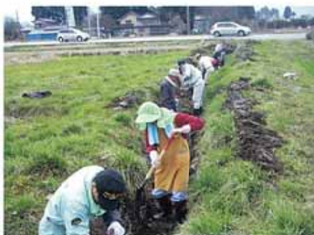
水路の泥上げ作業
