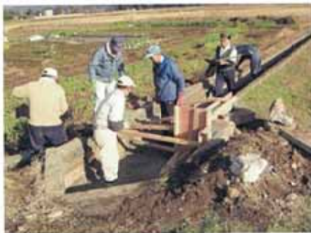
用水路法面の陥没箇所補修
