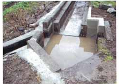
用水路内の陥没箇所の補修
