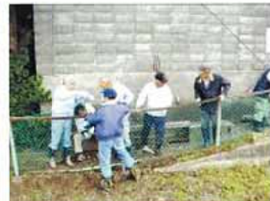
フェンスの金網張りかえ
