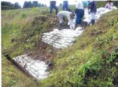
用水路法面の陥没箇所補修
