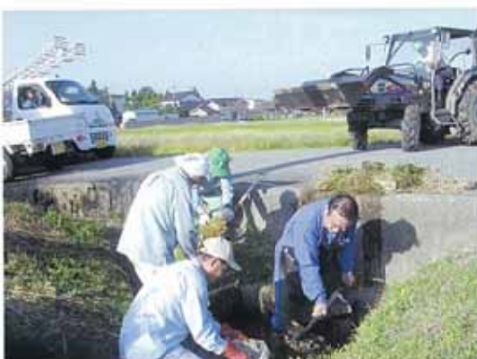
水路の泥上げ作業
