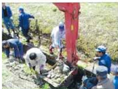
排水路からの重機による土石除去
