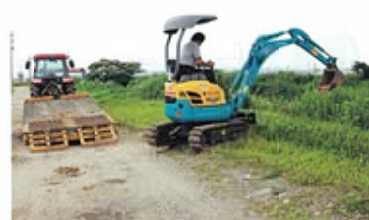
農道の補修(砂利敷き)
