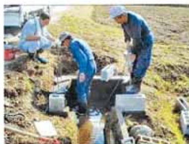
用水路補修（柵）
