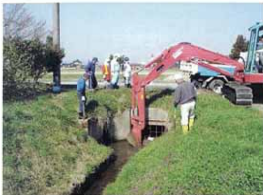
大型重機による排水路の江浚い (2008/4/6)
