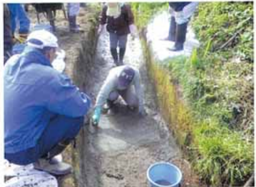
用水路内の陥没箇所の補修
