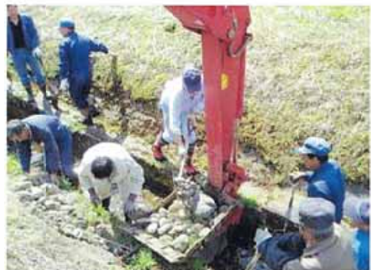
大型重機による排水路の江浚い (2008/4/6)
