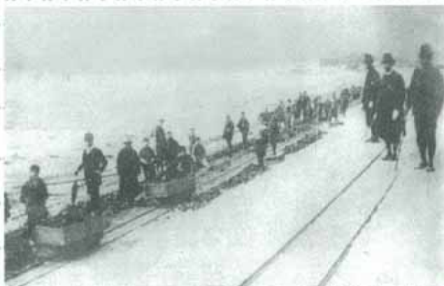
森山知事による工事視察の様子 出典:常西合口用水誌(3)
