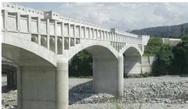
アーチ型の左岸連絡水路橋
