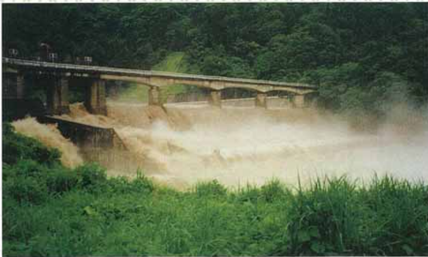
横江頭首工を流下する土石流
