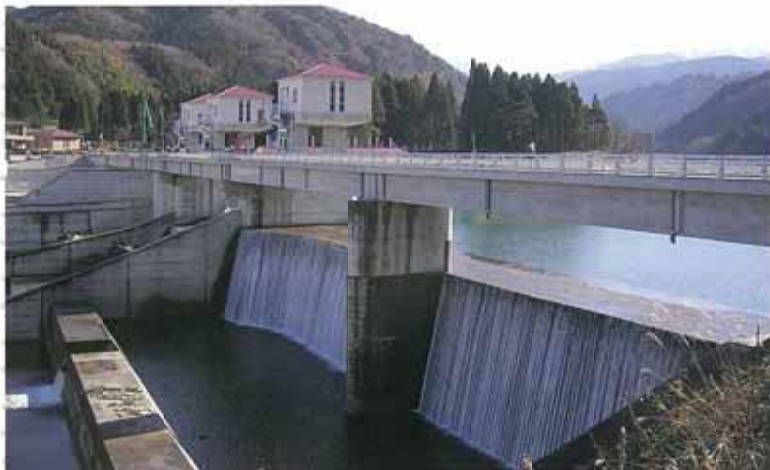
完成した横江頭首工
