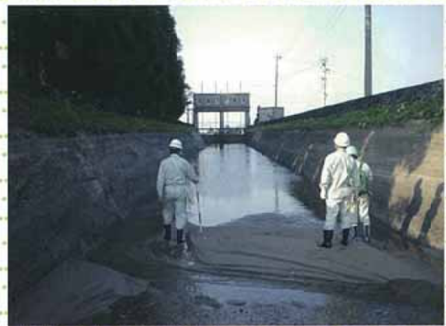
水路の点検の様子
