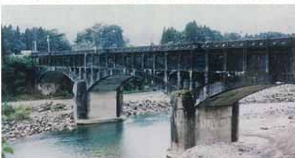
平成 10 年の左岸連絡水路橋
