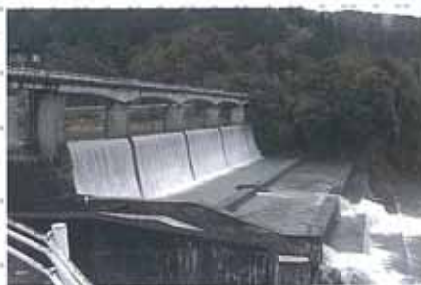
取水が一本化された横江頭首工
