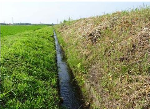
浸食土砂により水路天端が消失
