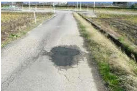
補修工事は、前回同様圧迫硬化型のアスファルト補修剤を使用した簡易補修です。少々見積が甘かったようで、もう1袋ほど入れた方が良かったみたいです。(合掌)
