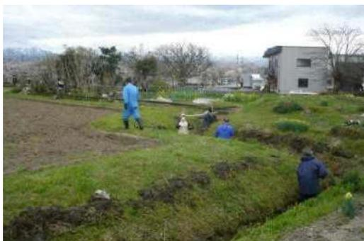
この排水路、終端は京坪川に落水しているのですが、設計か工事のどちらが原因かは不明だが、京坪川堤防下の土管入口側の水路が入口下部より20cmぐらい下がっているとい
