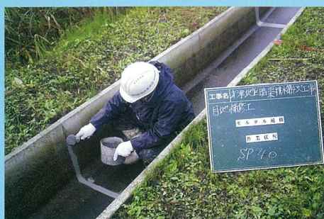
欠損部モルタル補修作業
