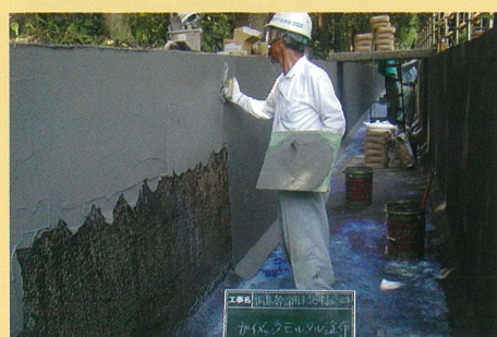
主剤 粗付け・仕上げ塗り作業
